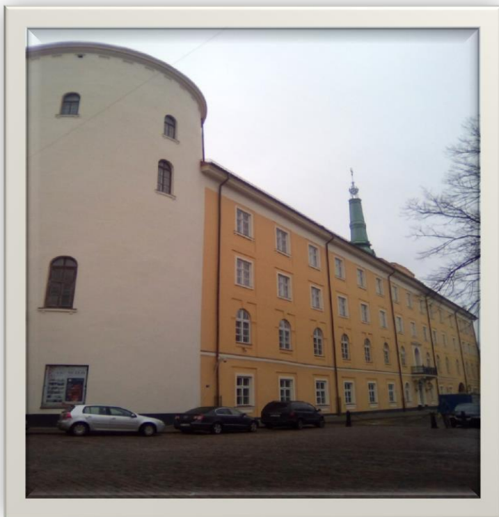
Rīgas pils daļa pēc rekonstrukcijas.
